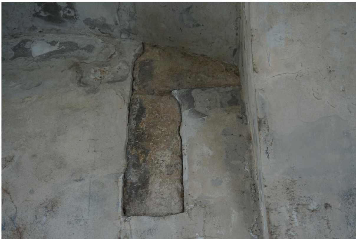
Jižní fasáda průjezdu brány. Pískovcové ostění okna pod vrstvou omítek, původně ošetřeno vápenným nátěrem. Po ubourání části hospodářských budov zámku bylo ostění zazděno.
