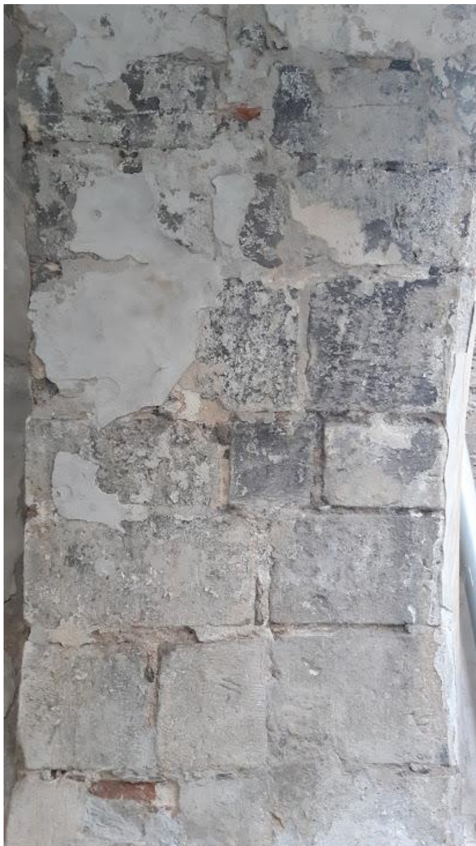
Pískovcový oblouk zámecké brány. Detail spárořezu a poškozených, opravných vrstev nátěrů a štuky. Povrch pískovce byl v minulosti natřen vápennou barvou. Později přibýly opravné vrstvy omítek.
