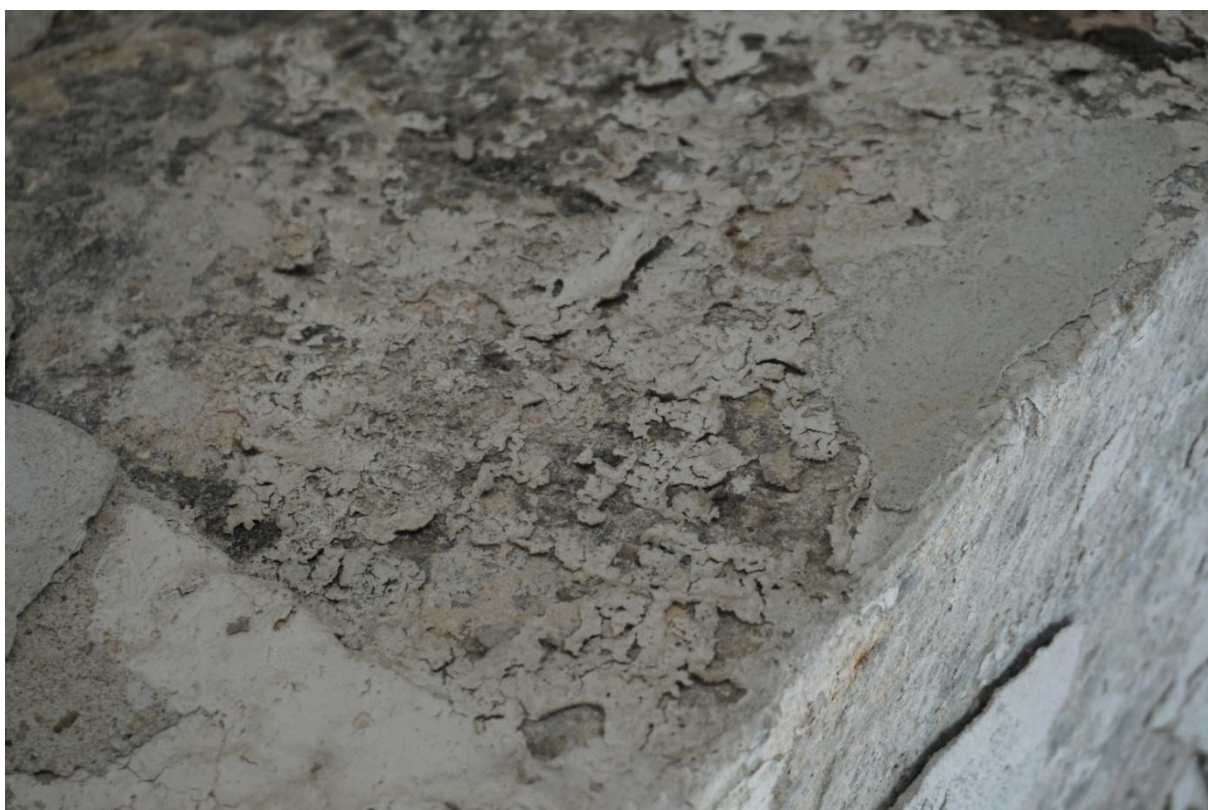
Detail poškozených, opravných vrstev nátěrů a štuky. Uvolněné spáry.
