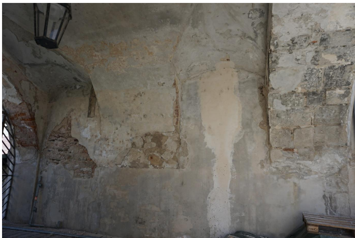
Jižní fasáda průjezdu brány. 1-cihlový oblouk, 2 – lomový kámen –zdivo, 3 - pískovcové ostění, 4 – pískovcové kvádry – oblouk brány.
