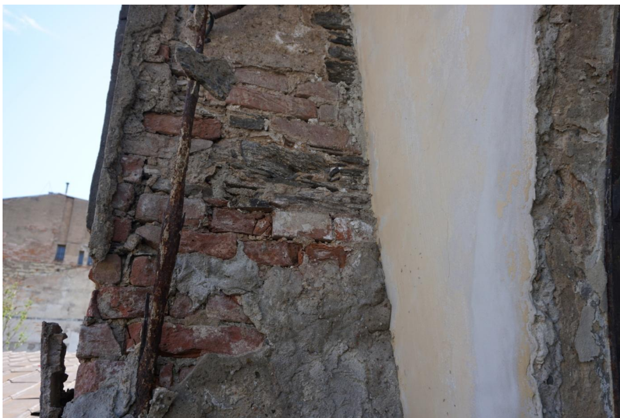
JV oblouk brány. Cihlové zdivo. Nad průjezdem brány docházelo v minulosti k zatékání srážkové vlhkosti. Poškozené nové omítky. Opěrný pilíř s fragmenty starších omítek.
