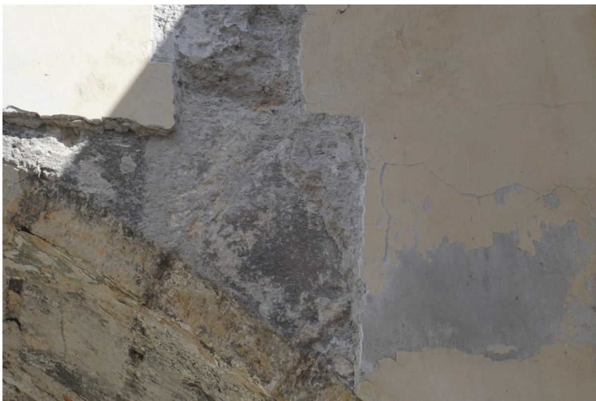
Sonda odhalených pískovcových kvádrů a přechod do omítkových ploch.
