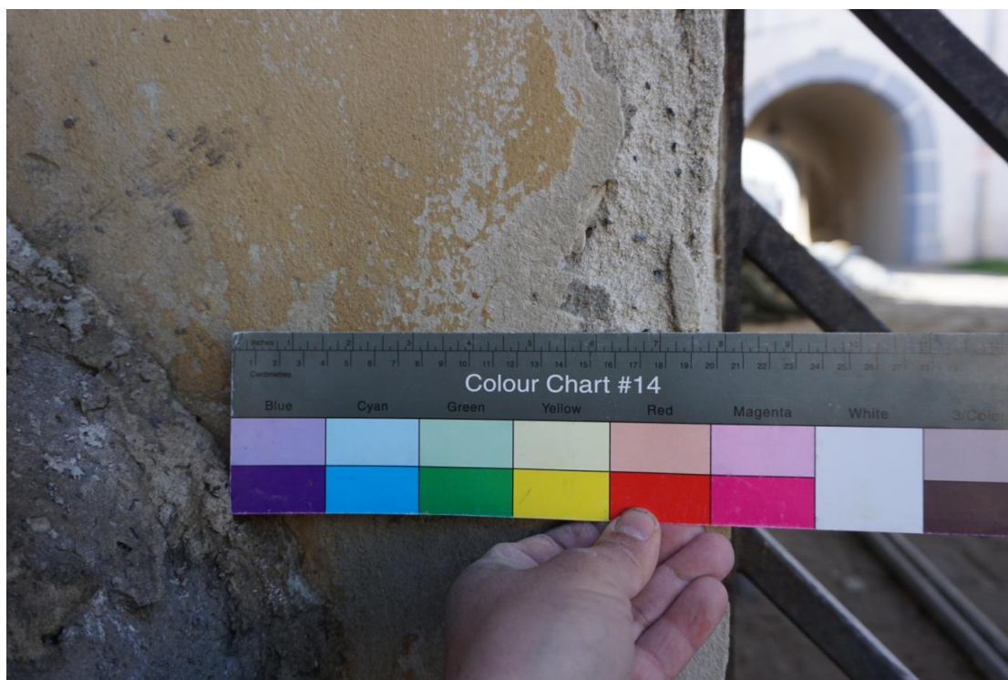
Současný nátěr – okr/ s barevnou škálou. Opravné sanační omítky(bílá) + cementové omítky (šedá). Novodobá kovaná mříž.
