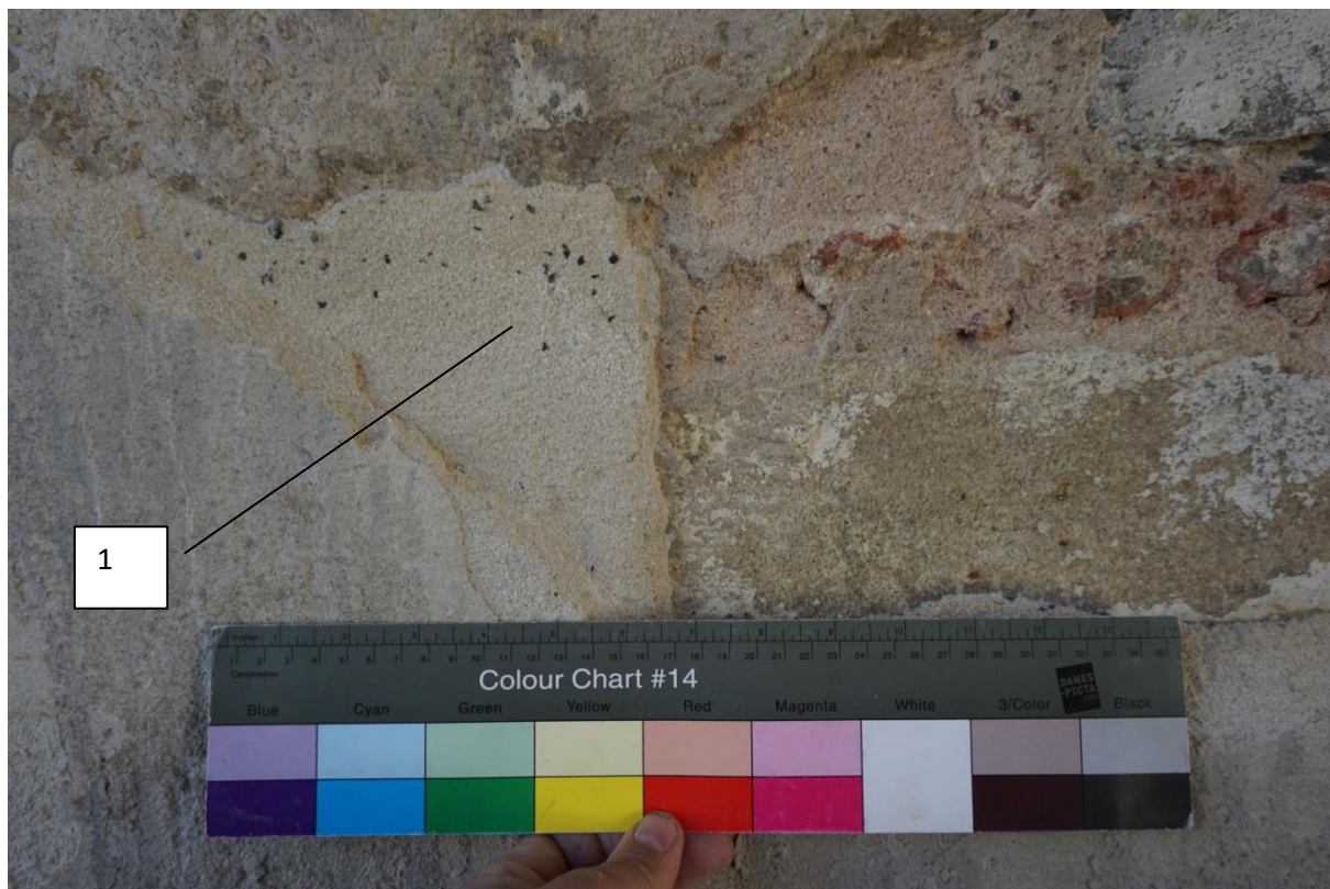
Opravné sanační omítky. Smíšené zdivo (pískovec, cihla, lomový kámen)
