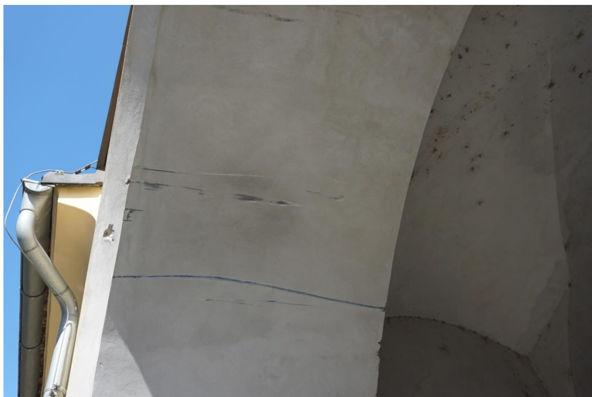
SZ strana brány. Poškozené nové omítky průjezdem nadměrných nákladů.
