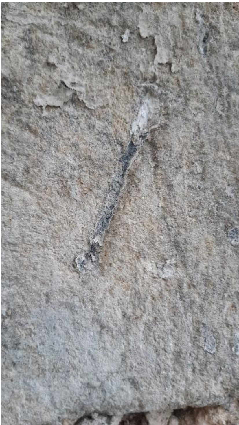
Kamenické značky. /0-pískovec, 1-bílý vápenný nátěr, 2-černý nátěr v hloubce/
