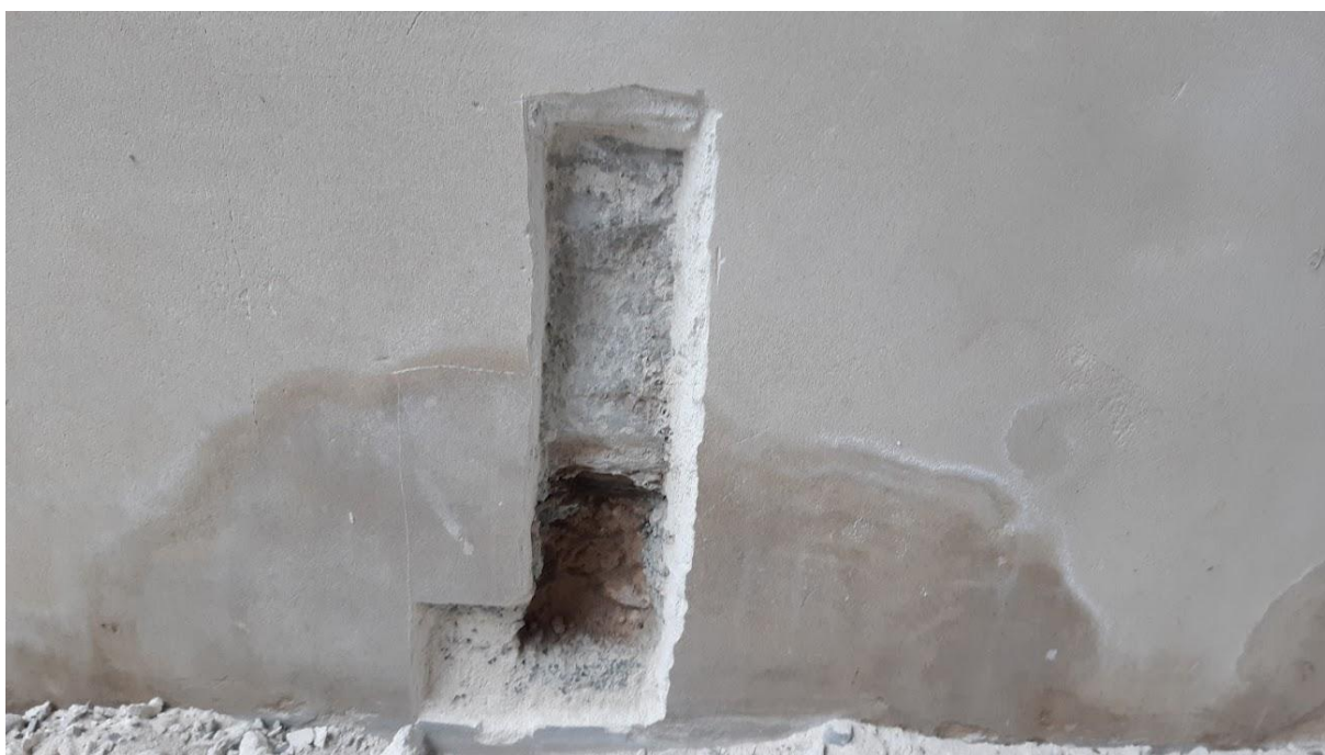
Z fasáda brány. Sonda v místech poškození nové omítky (praskliny, spodní vlhkost) odhalující lomové zdivo a zvýšený obsah vodorozpustných solí.
