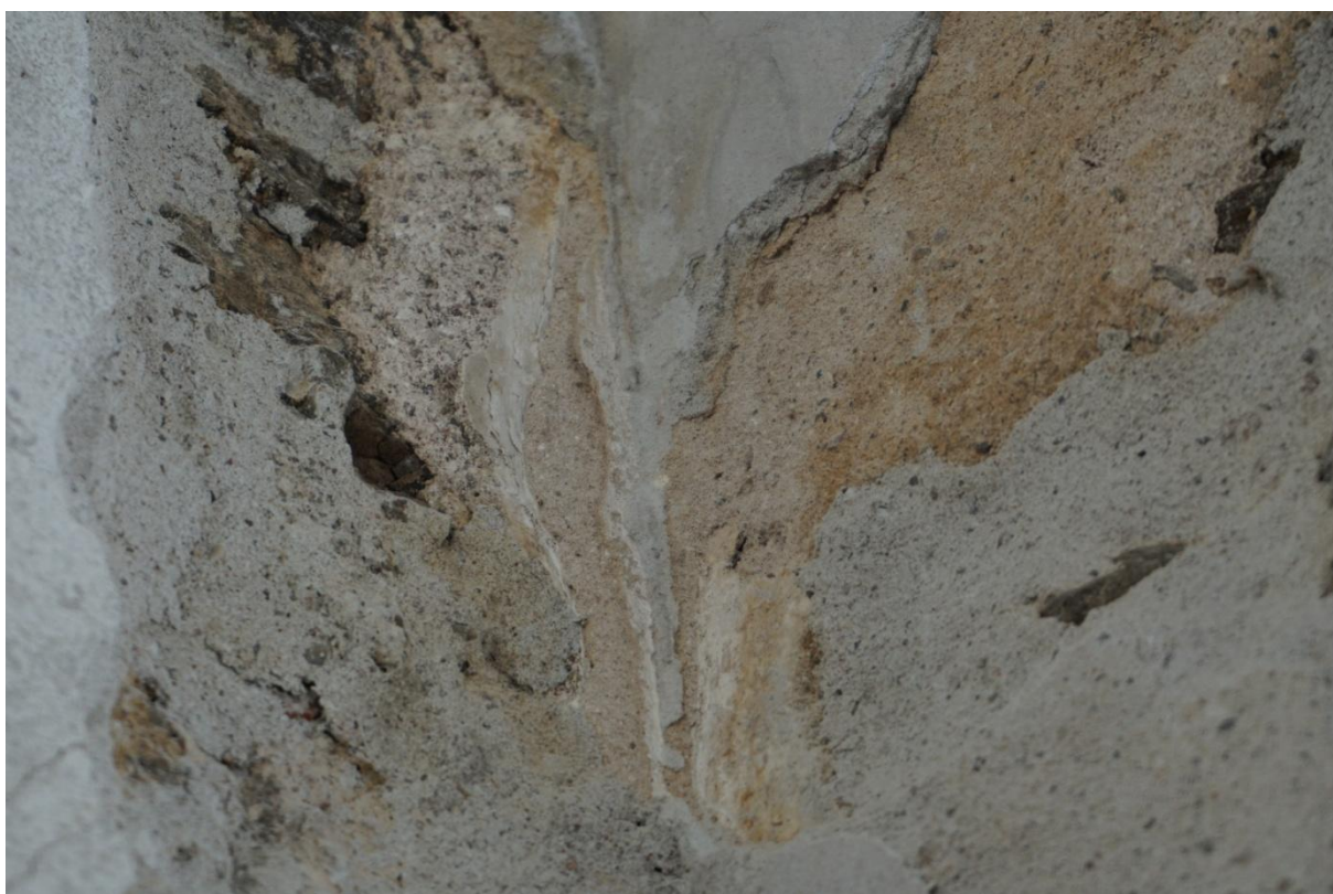
Detail poškozených opravných omítkových vrstev.
