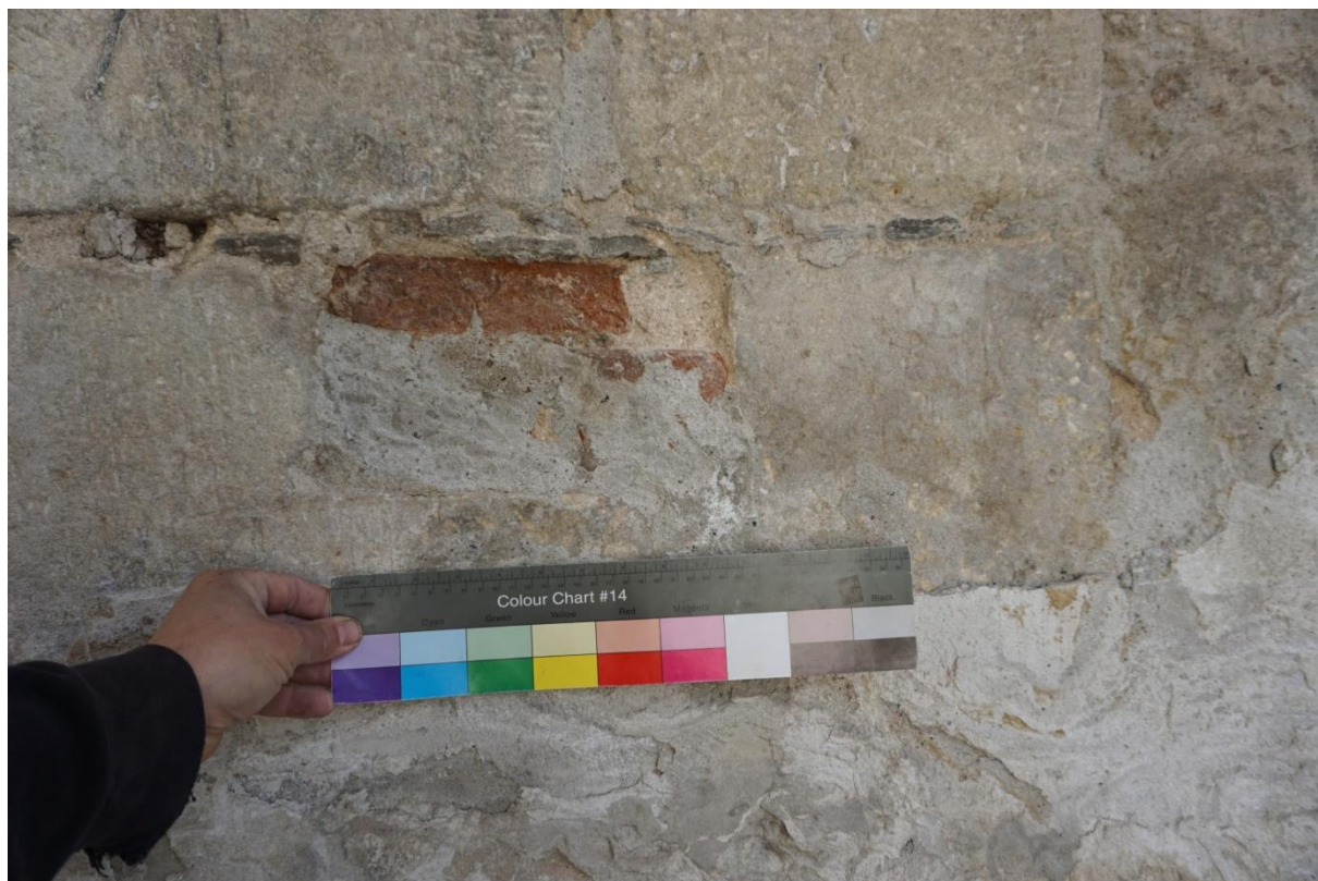
JZ oblouk brány. Zazděná kapsa cihlou. Spáry proložené břidlicí.
