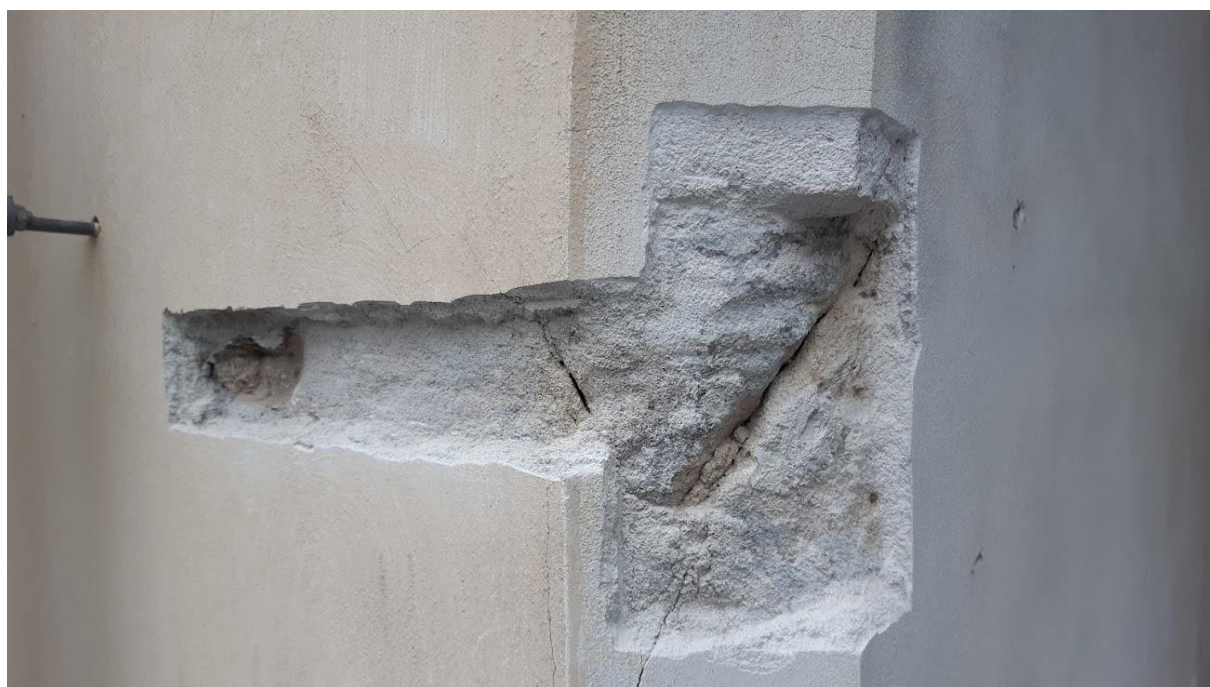
Západní strana brány. Sonda odhalených pískovcových kvádrů. Trhliny v pískovcovém kvádru.
