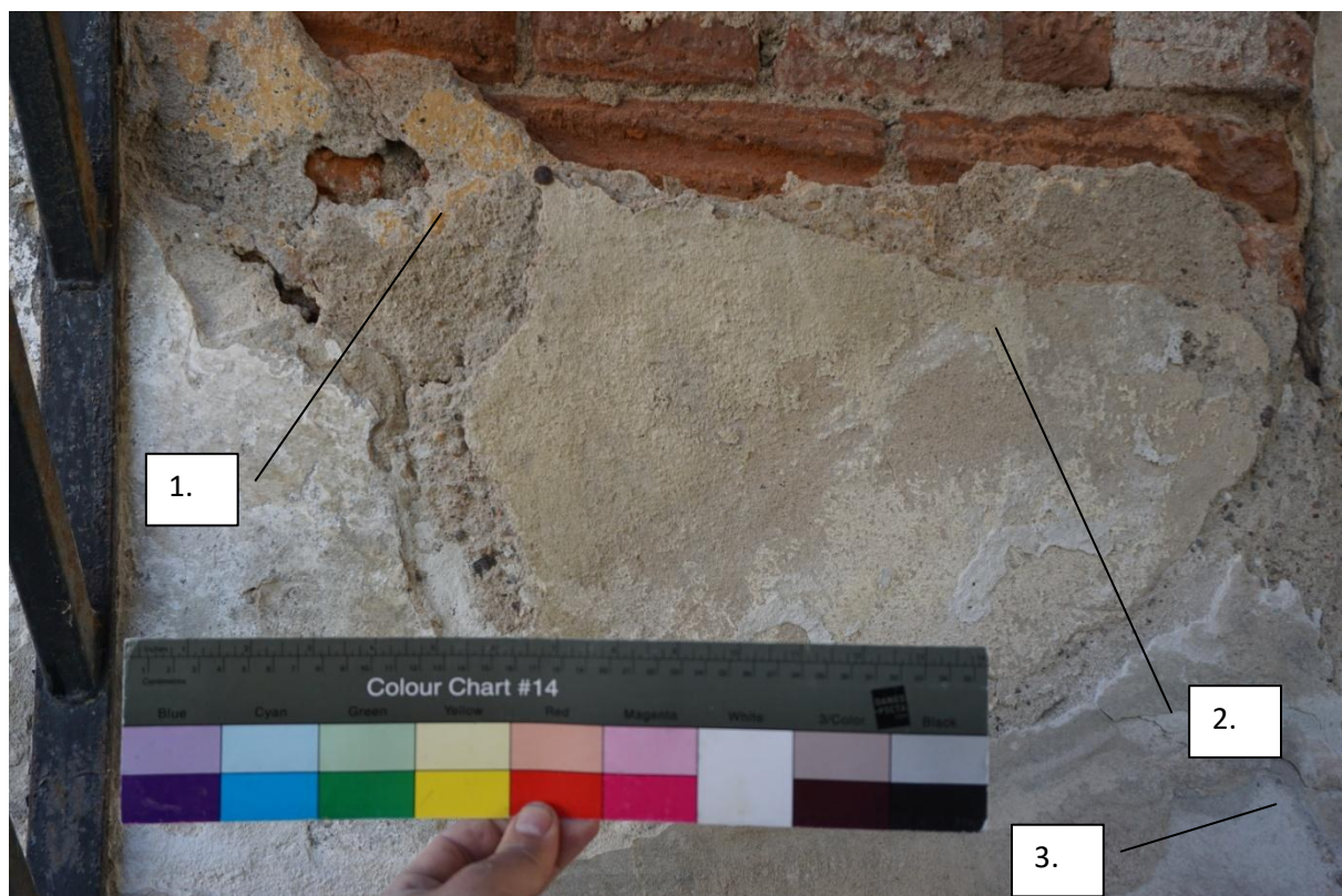
JV oblouk brány. Několik navazujících opravných omítek s odlišnou barevnou úpravou. 1- dochovaná nejstarší vrstva omítky, 2- mladší vrstva opravné omítky (béžová), 3- nejmladší opravná vrstva omítky (sanační).
